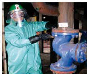
Figure 7 : Exemple de bonne pratique lors de l'ouverture d'un circuit
