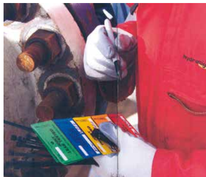
Figure 10 : Étiquetage selon intervention en cours
