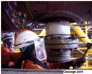
Figure 6 : Exemple de bonne pratique lors du cassage d'un joint
